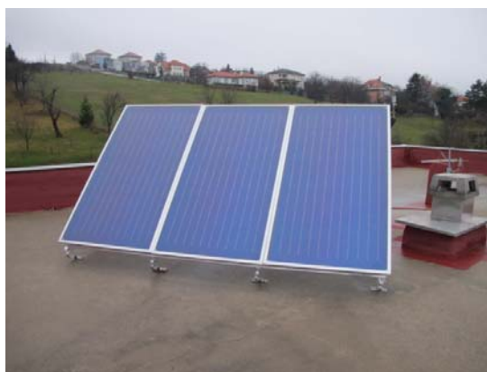
Slika 2 Pločasti solarni kolektori
