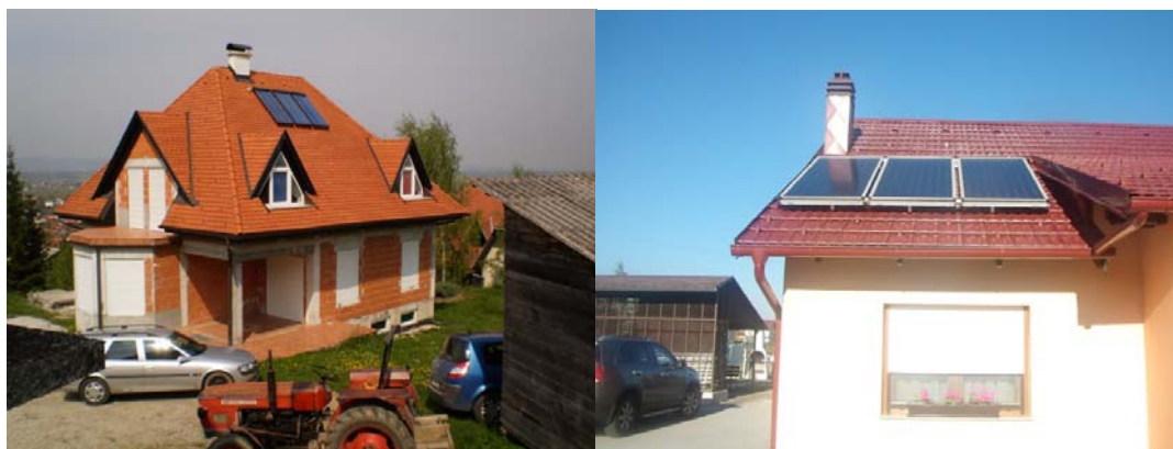
Slika 1 Solarni kolektori na krovu obiteljskih kuća
